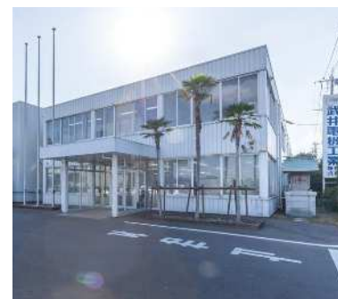
武井電機工業(株) 社屋
