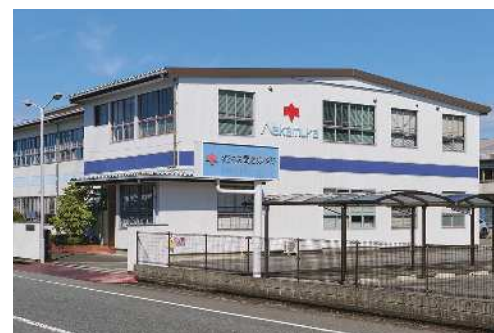
(株)中村電機製作所 社屋
